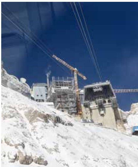
Die Seilbahn-Bergstation wird in großen Bereichen umgebaut.
