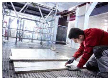
Zur Erfüllung der F-90-Anforderungen wurde die formstabile „Conlit Steelprotect Board Alu“ eingesetzt. Die Platten lassen sich einfach vor Ort zuschneiden und passen sich schwierigen Bauteilgeometrien an.
