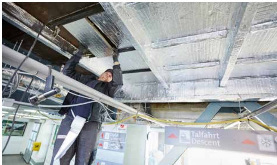
Durch den Umbau gelten neue Auflagen: Bestehende Stahl- und Betonbauteile wurden mit Brandschutzplatten von ROCKWOOL ertüchtigt.
