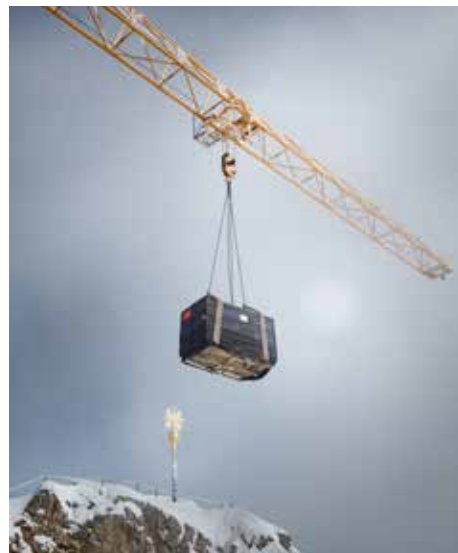
Das Baumaterial transportieren im letzten Abschnitt zwei Baukräne.
