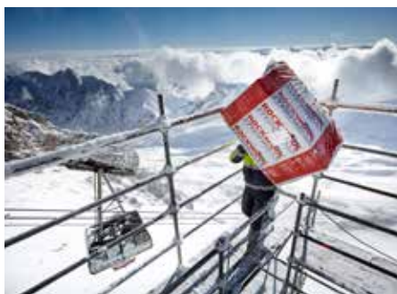
Kalter Arbeitsplatz mit Aussicht: Der Umbau wurde teilweise bei Minustemperaturen durchgeführt.
